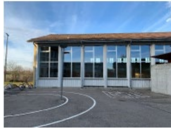
Schulhaus Paul Klee Turnhalle
