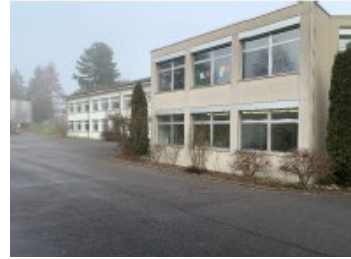
Schulhaus Bodenacker Trakte 2 und 3, sowie Spezialtrakt
