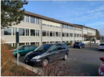
Schulhaus Waldegg West- und Osttrakt
