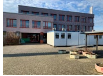
Schulhaus Riedli Hauptgebäude und Nordtrakt
