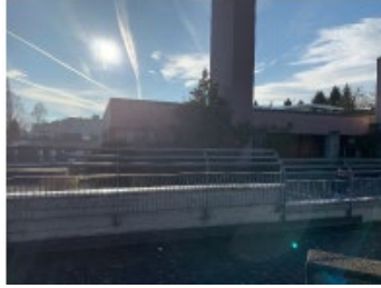
Schulhaus Riedli Südtrakt mit Abwartswohnung
