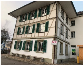
Schulhaus Dorf; Tagesschule
